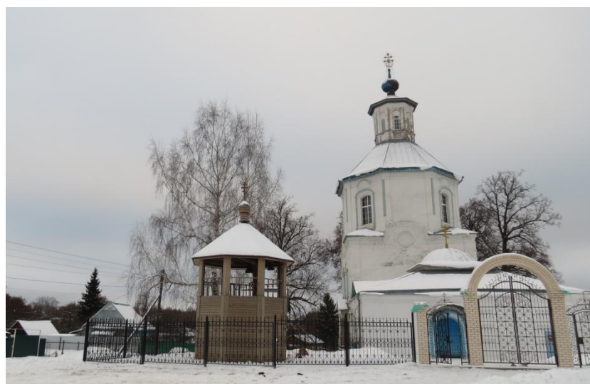
Вид запада. Фото декабрь 2018 г.
